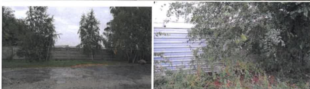
Rysunek 6 - Pawilony z klatkami i ogrodzenie nieruchomości, źródło: wizja lokalna.
